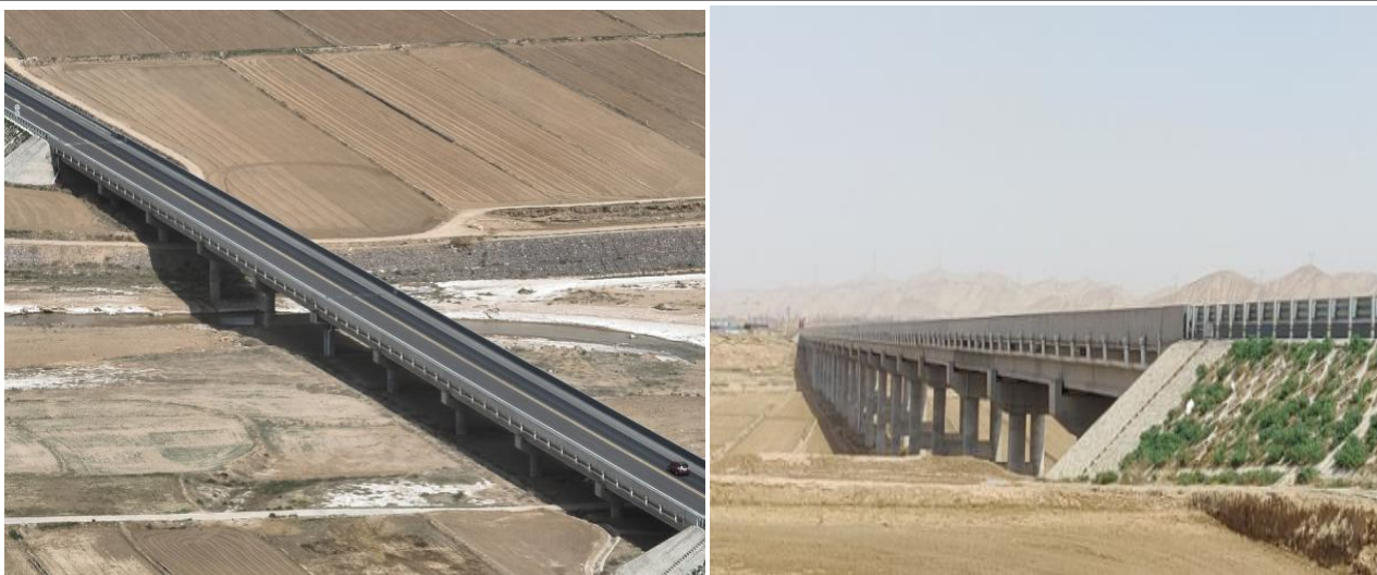
图 4-2 桥涵工程现状图
