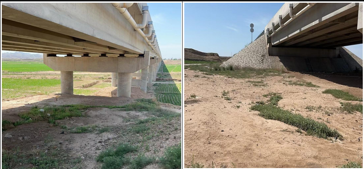
桥梁工程桥下现状
