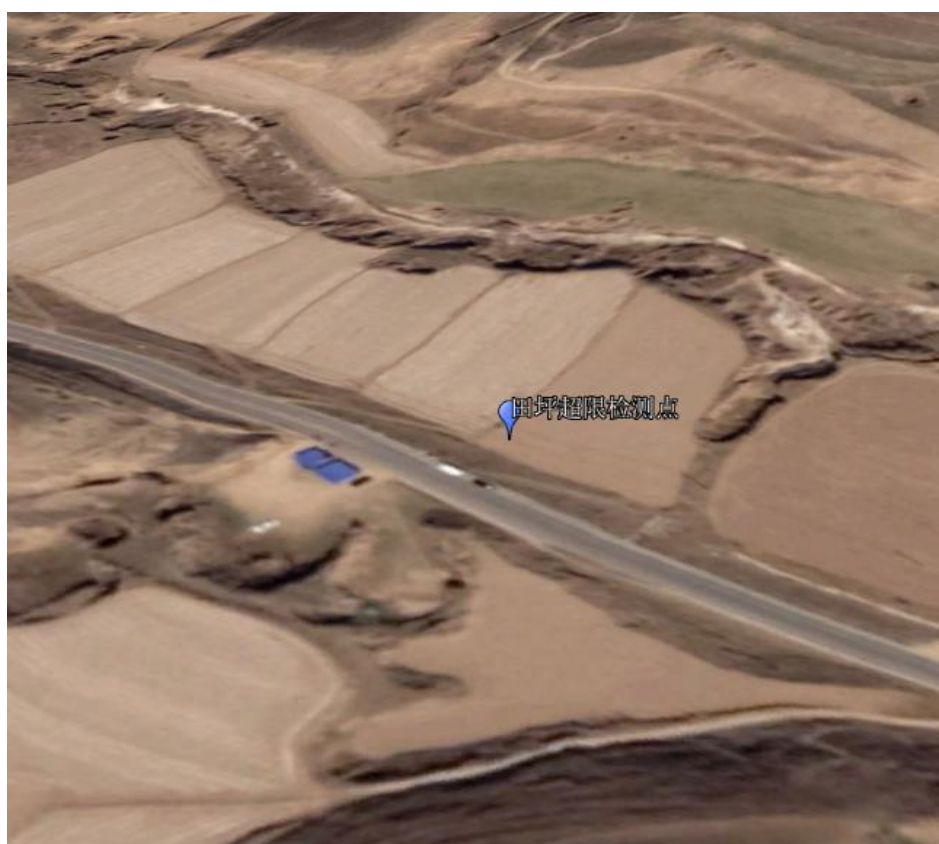
D.现场现状照片
