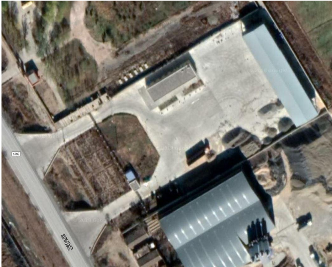
D.现场现状照片
