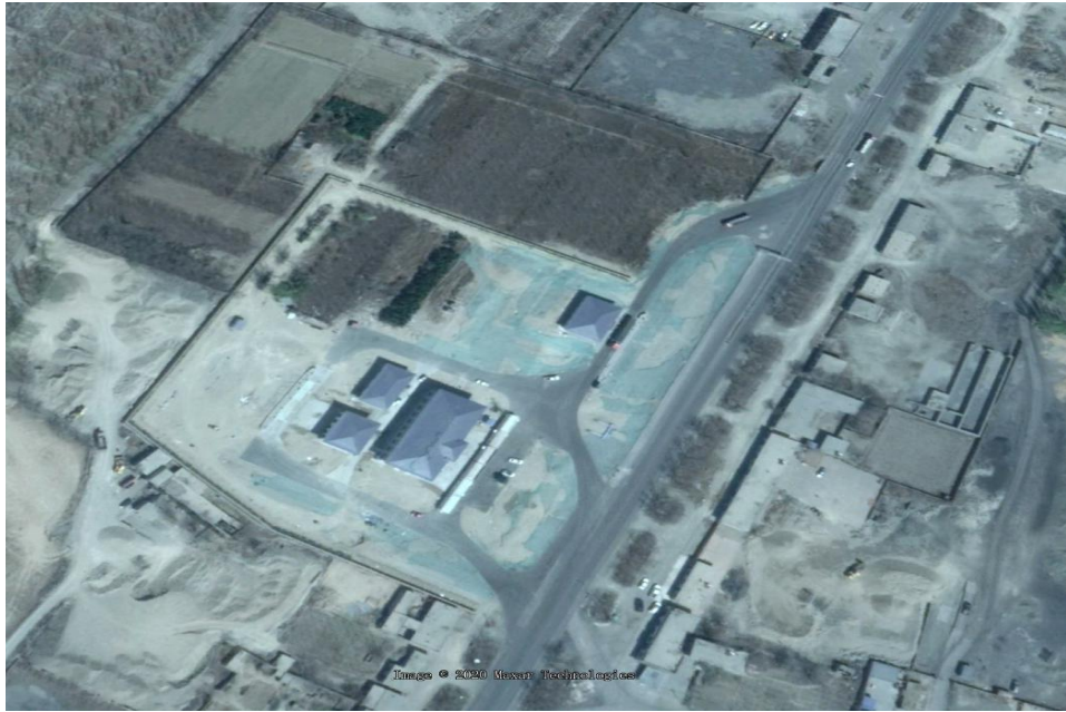
D.现场现状照片
