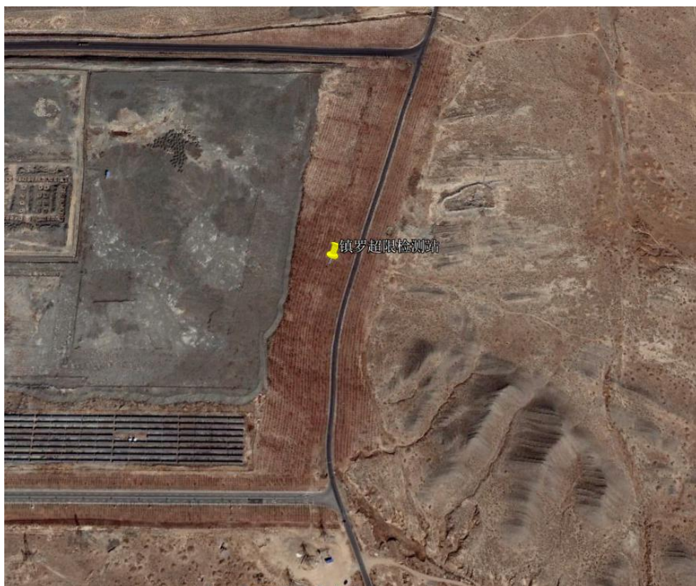
D.现场现状照片
