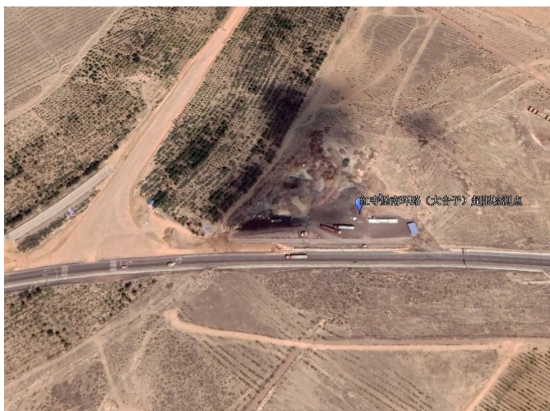
D.现场现状照片
