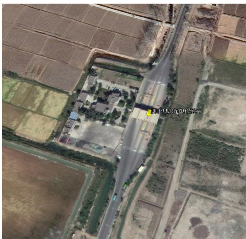
D.现场现状照片
