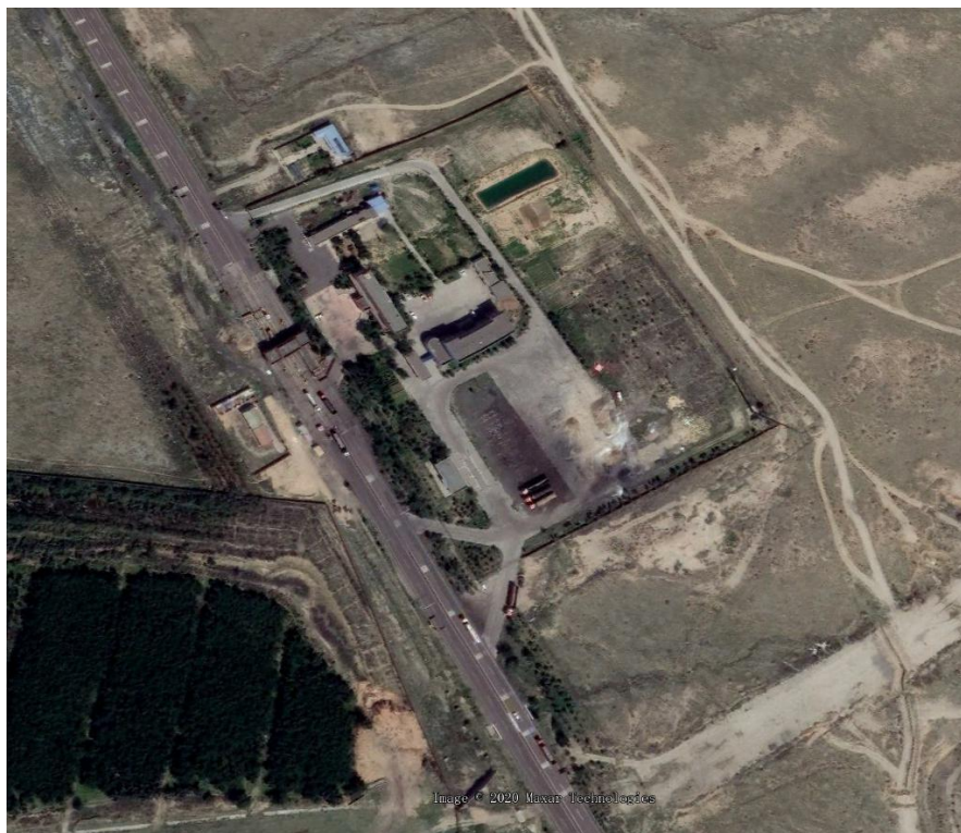
D.现场现状照片
