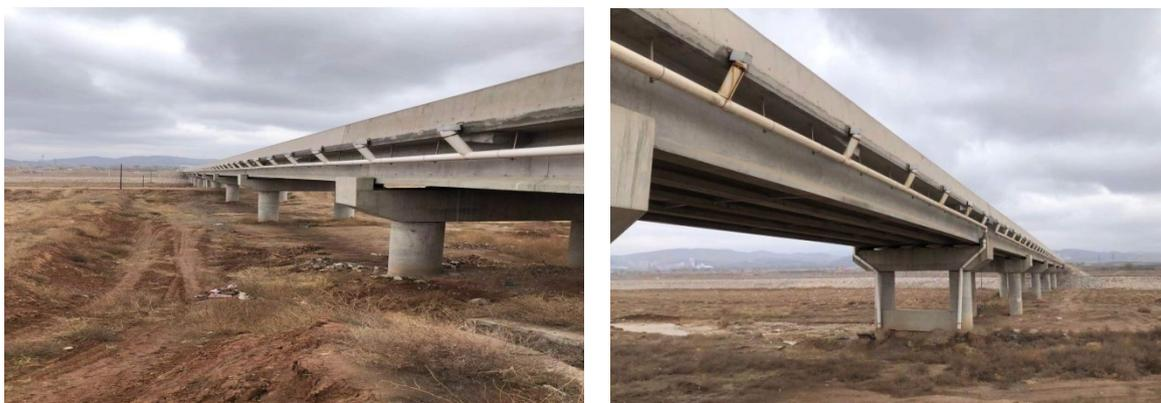
图 7-1 桥面设置的排水设施
