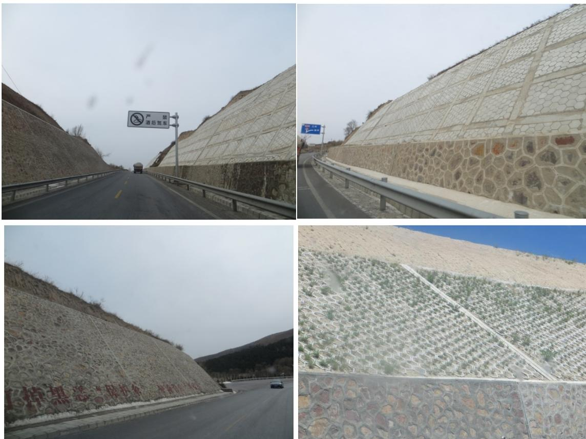
图 5.3-4 本项目典型边坡防护现场图片
