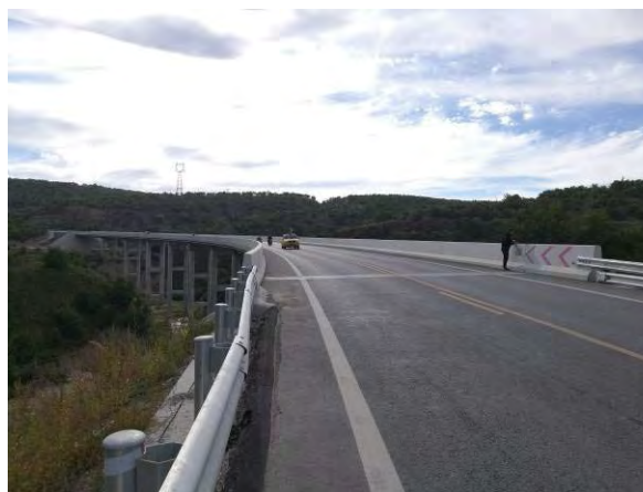
大涧沟桥现状
