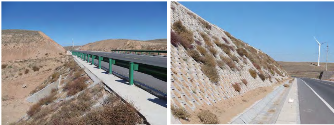
边坡工程防护和植草防护
