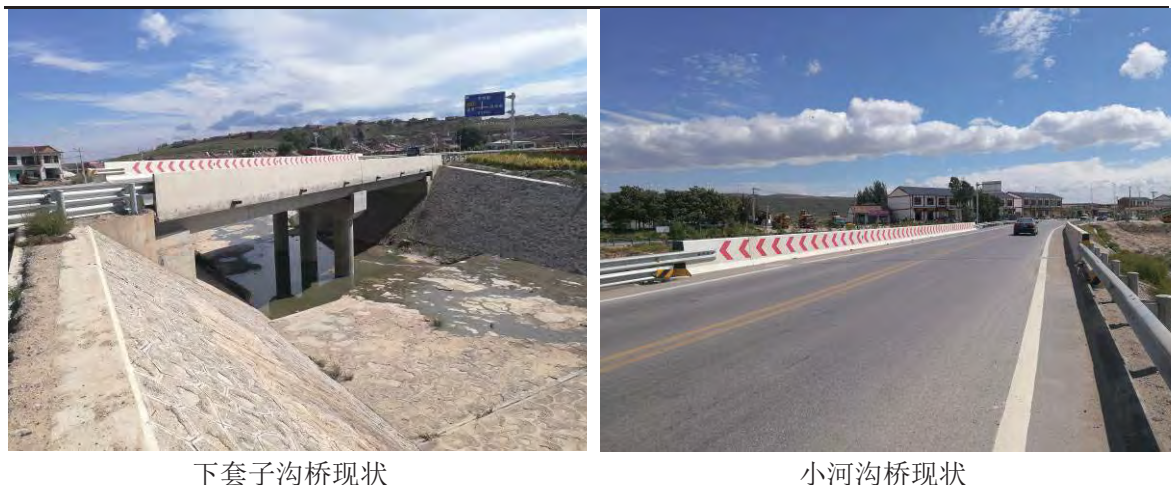
图 2.4-1 桥梁工程现状
