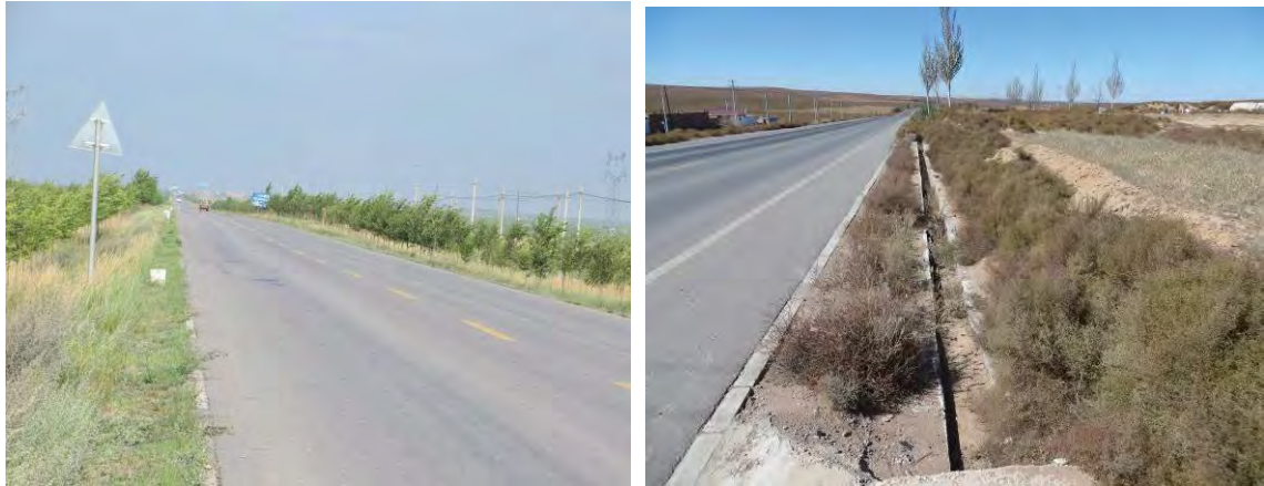
路基边坡草种恢复
