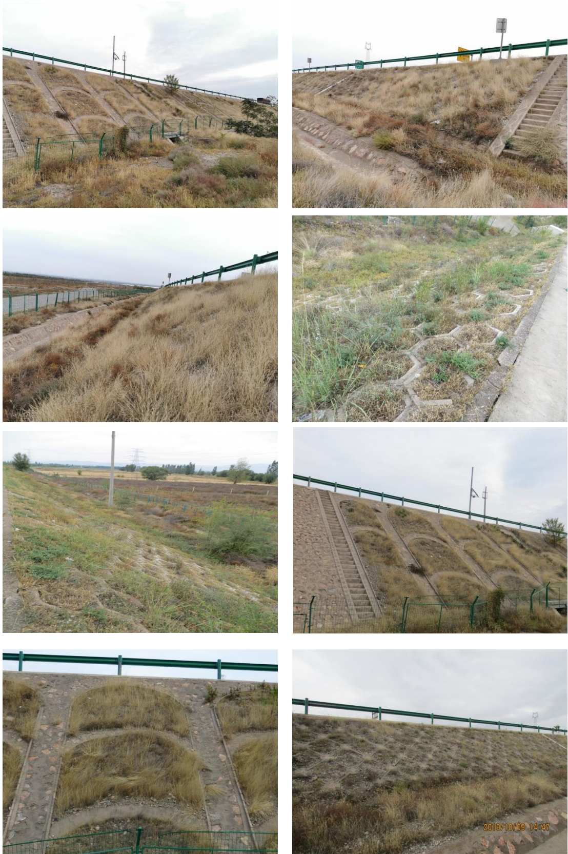
图 5.4-2 本项目典型边坡防护现场图片
