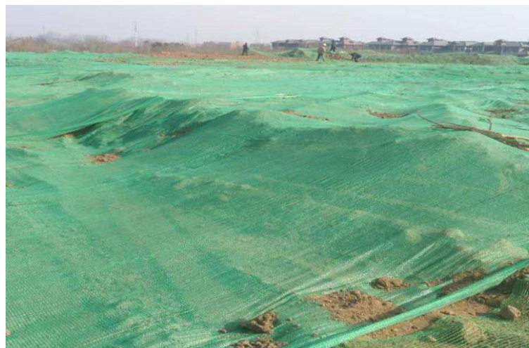
施工期物料篷布覆盖
