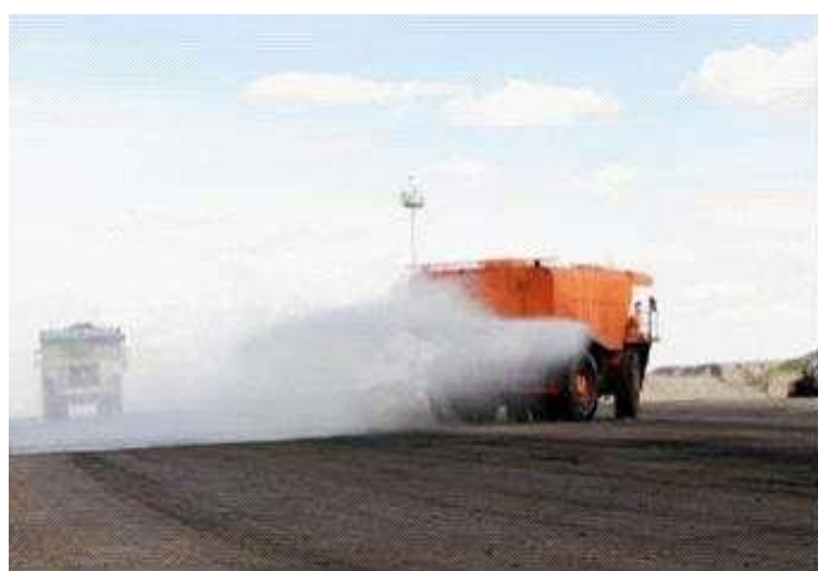
施工期洒水降尘
