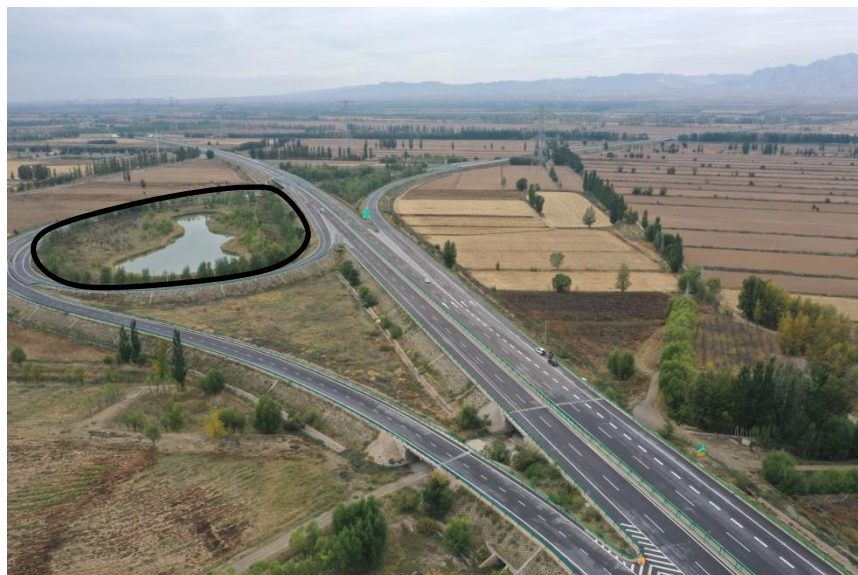
施工营地（K10+500 左侧 100m）
