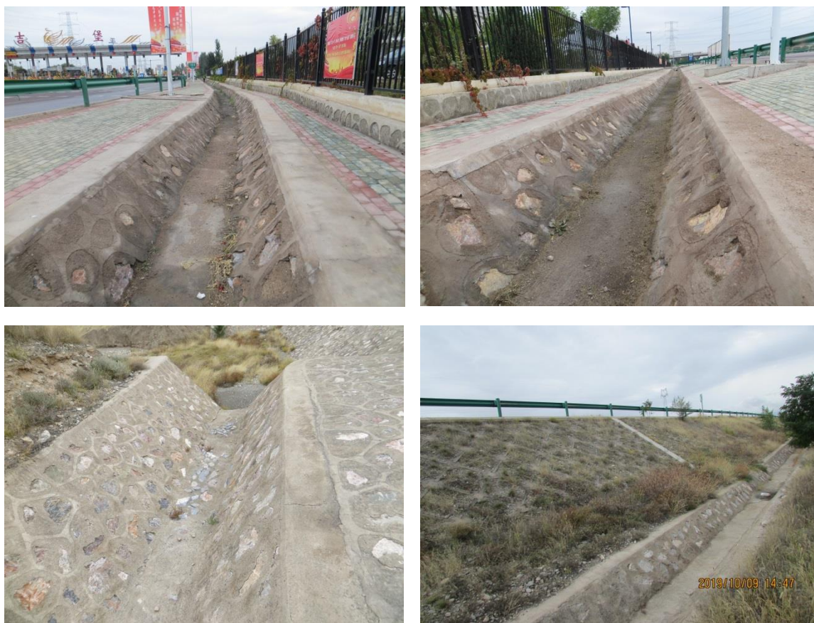
图 5.4-3 本项目典型公路排水设施现状
