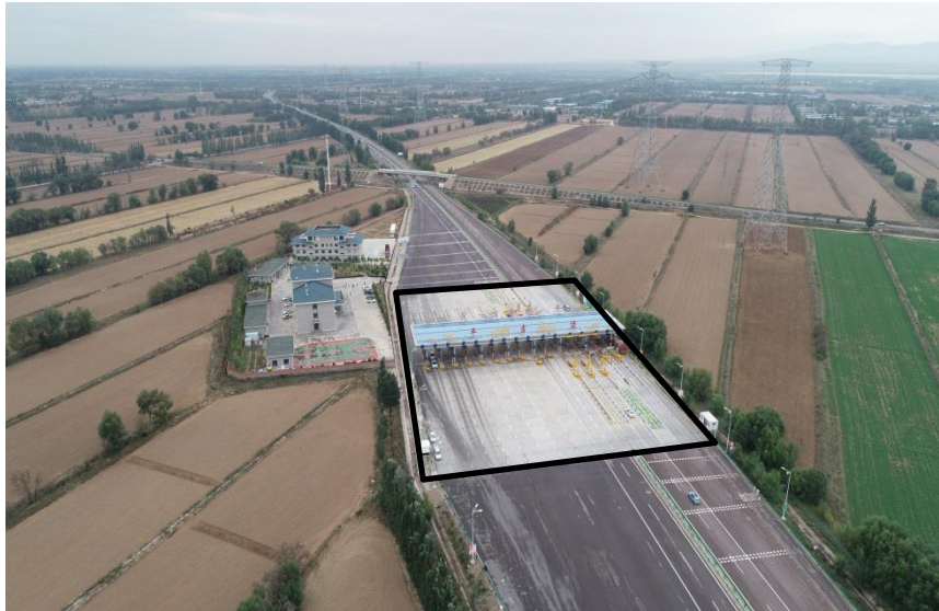
施工营地（K4+050 左侧 100m）
