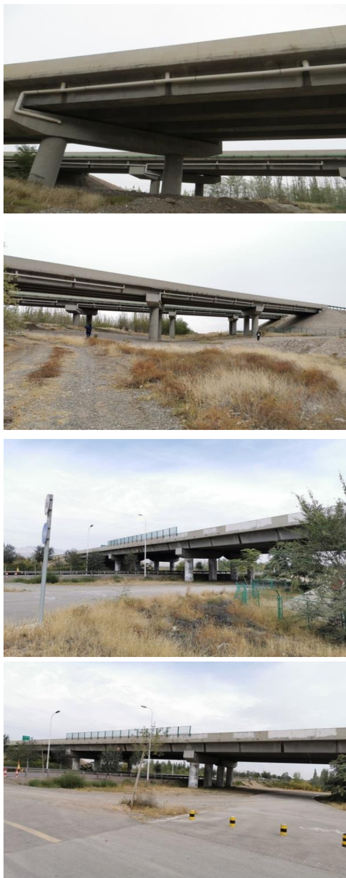
图 2.4-2 本项目桥梁工程现状
