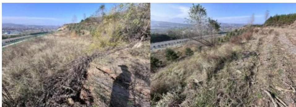
图 28 S25 泾华高速 K41+700 段滑坡局部蠕滑变形现场照片
