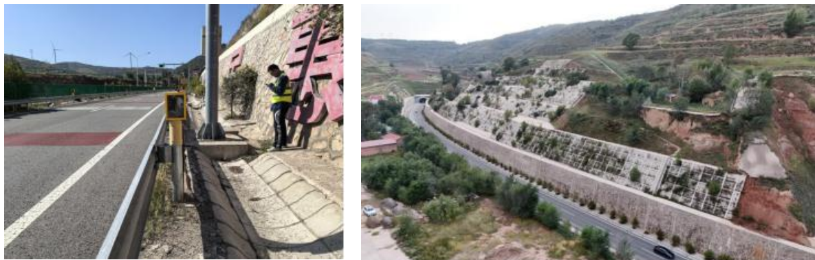
图 26 S60 线固西高速偏城隧道洞口现场照片
