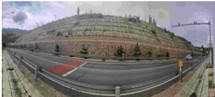
图 22 S60 固西高速 K31+500 段高边坡现场照片
